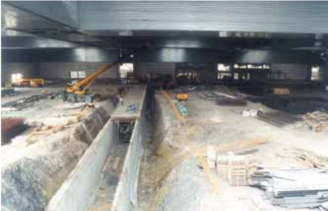
Galería de servicios en construcción (fuente: IDOM)
