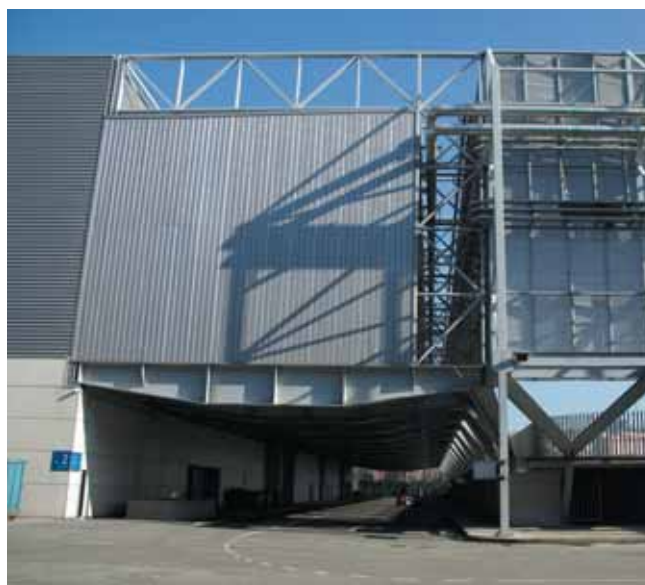
Zona elevada para albergar las instalaciones, permitiendo la circulación inferior (fot. J. Terés)
