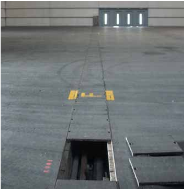
Canal de servicios con los registros abiertos (fot. J. Terés)
