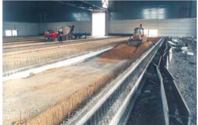
Canales de servicios en construcción (fuente: IDOM)
