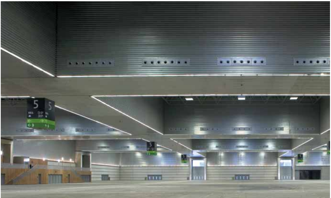
Interior de un pabellón iluminado: por su definición en el espacio general del pabellón, se ha querido remarcar aún más la presencia de las jácenas mediante la introducción de unas líneas continuas de luz que definen su contorno. Obsérvense la impulsión de aire acondicionado en el plano vertical de las jácenas (fuente: IDOM)
