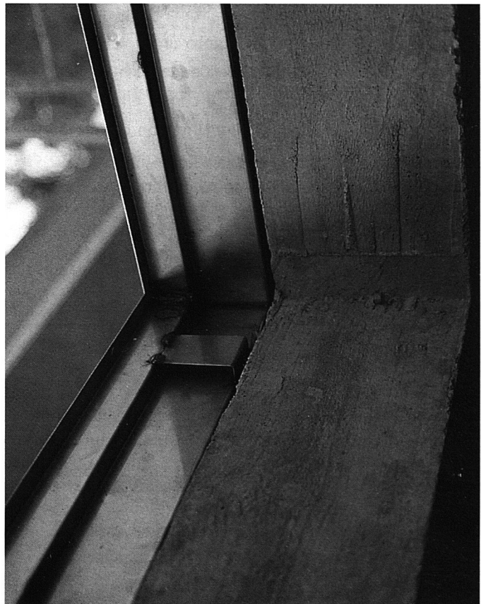
Muro de hormigón y premarco de ventana de acero inoxidable.
