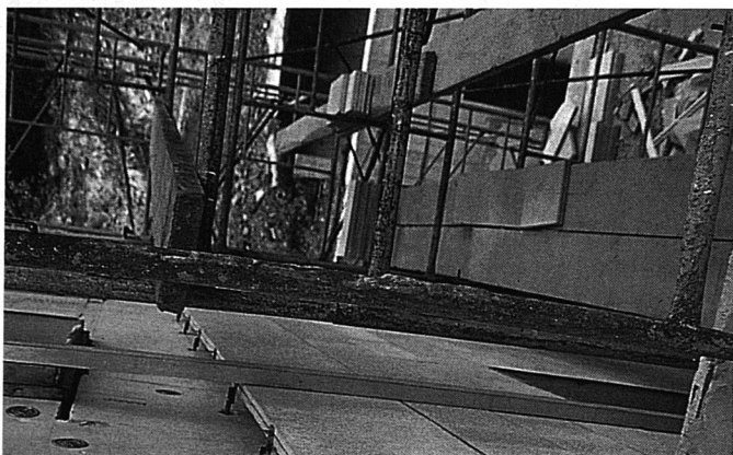
Anclaje fachada de terrazo.
