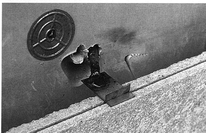
Detalle fijación terrazo.
