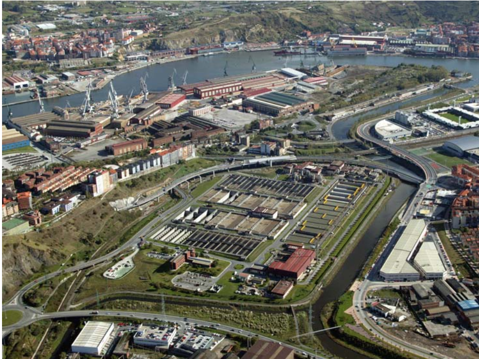
Figura 5.1. Vista panorámica de la EDAR de Galindo (Bilbao)
