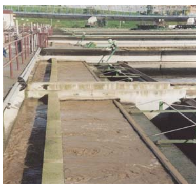
Figura 5.7. Purga de sólidos adicional en el decantador secundario
