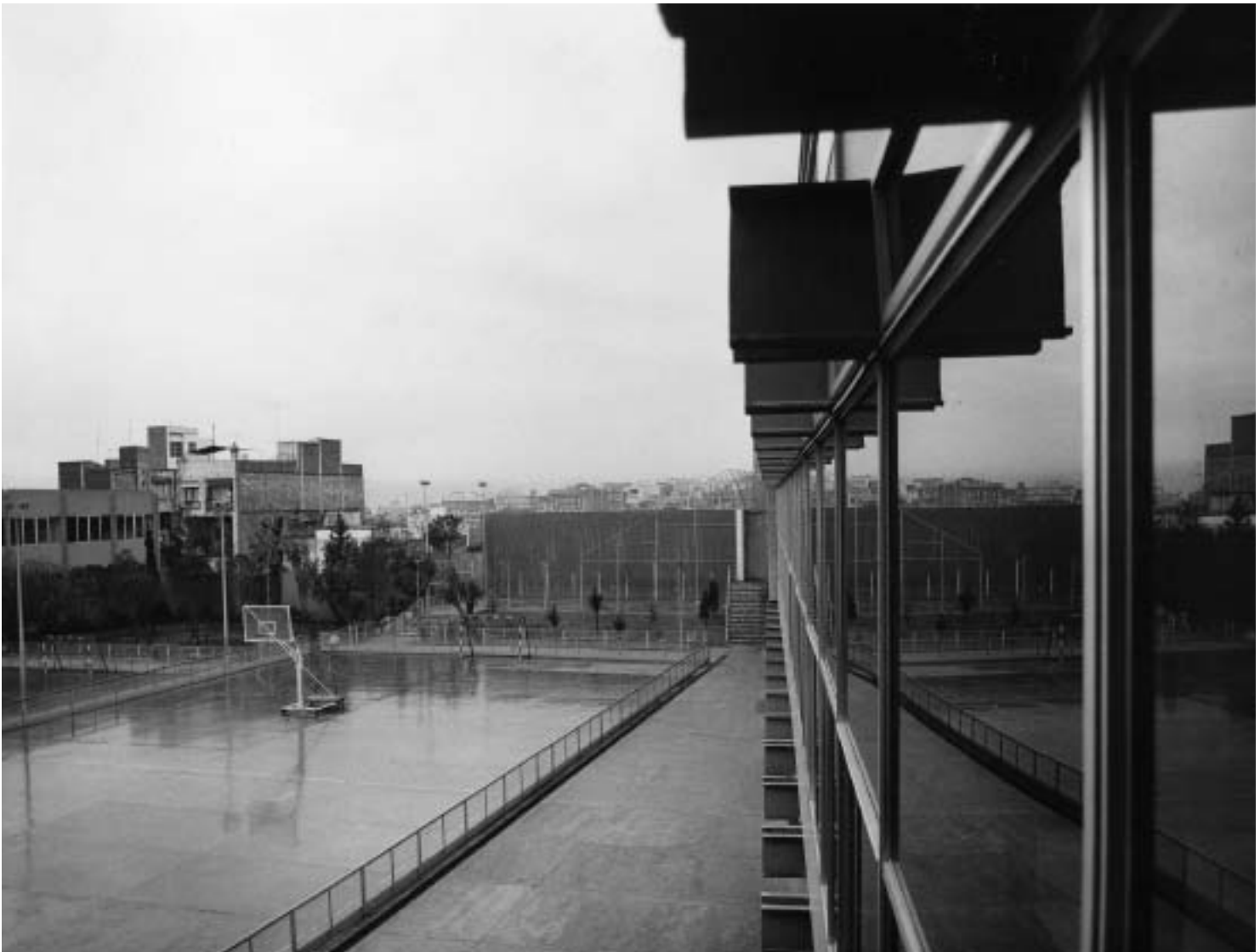
Fig. 13. La presencia industrial de los perfiles de acero proporciona estabilidad matérica a un edificio fundamentalmente ensamblado y ligero. Durante la obra, el acopio y movimiento aéreo de los perfiles debió imponer credibilidad técnica a la apuesta cronométrica de Cabrero (Fotografía de Catalá-Roca).
