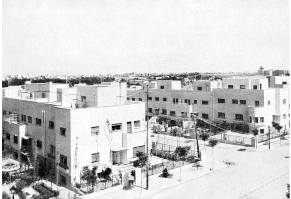
Fig. 4. Colonia el Viso . Calle Serrano. Madrid, 1933-1936. Vista hacia el norte de los bloques desde la calle Doctor Arce. Arq. Rafael Bergamín.
