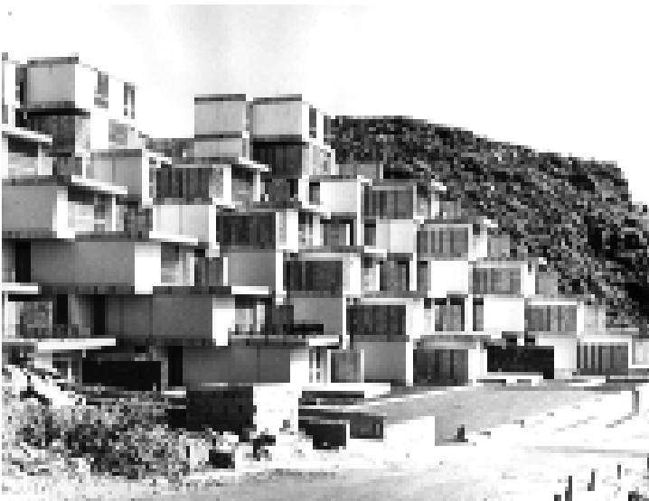
Vista del conjunto durante las obras.
