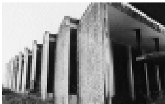
Iglesia. Detalle de los muros laterales.
