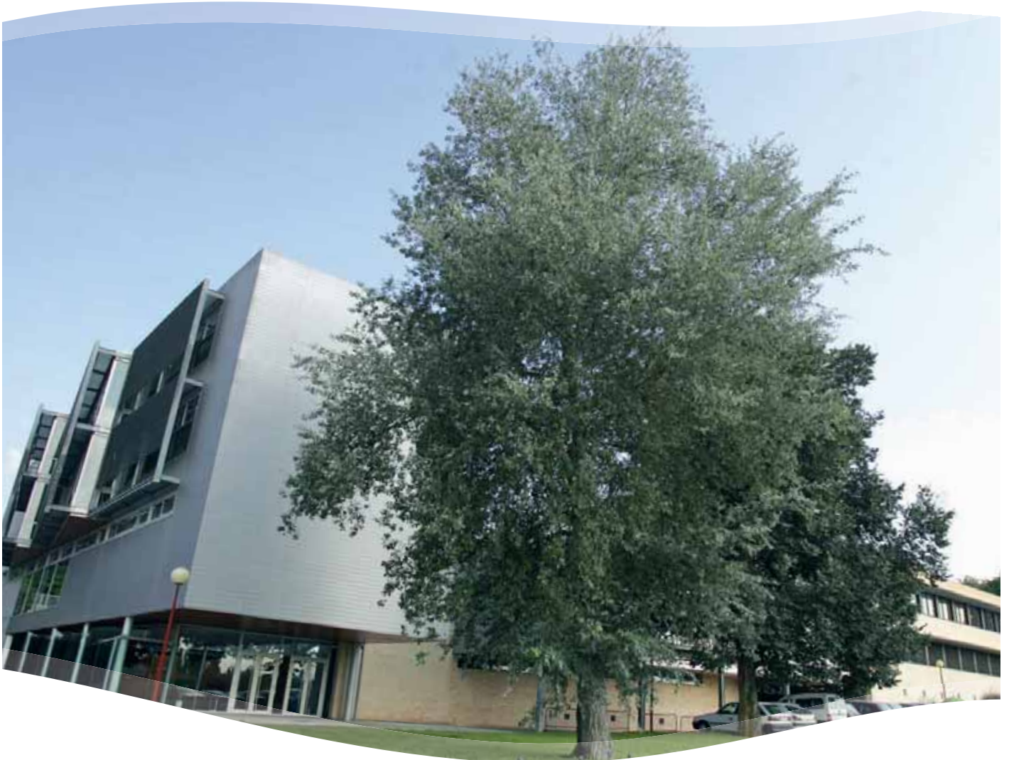
Edificio Biblioteca de Ciencias - 1990. Arquitectos: Ignacio Araujo, Mariano González Presencio, Inmaculada Jiménez Caballero y Aurora Barrio
