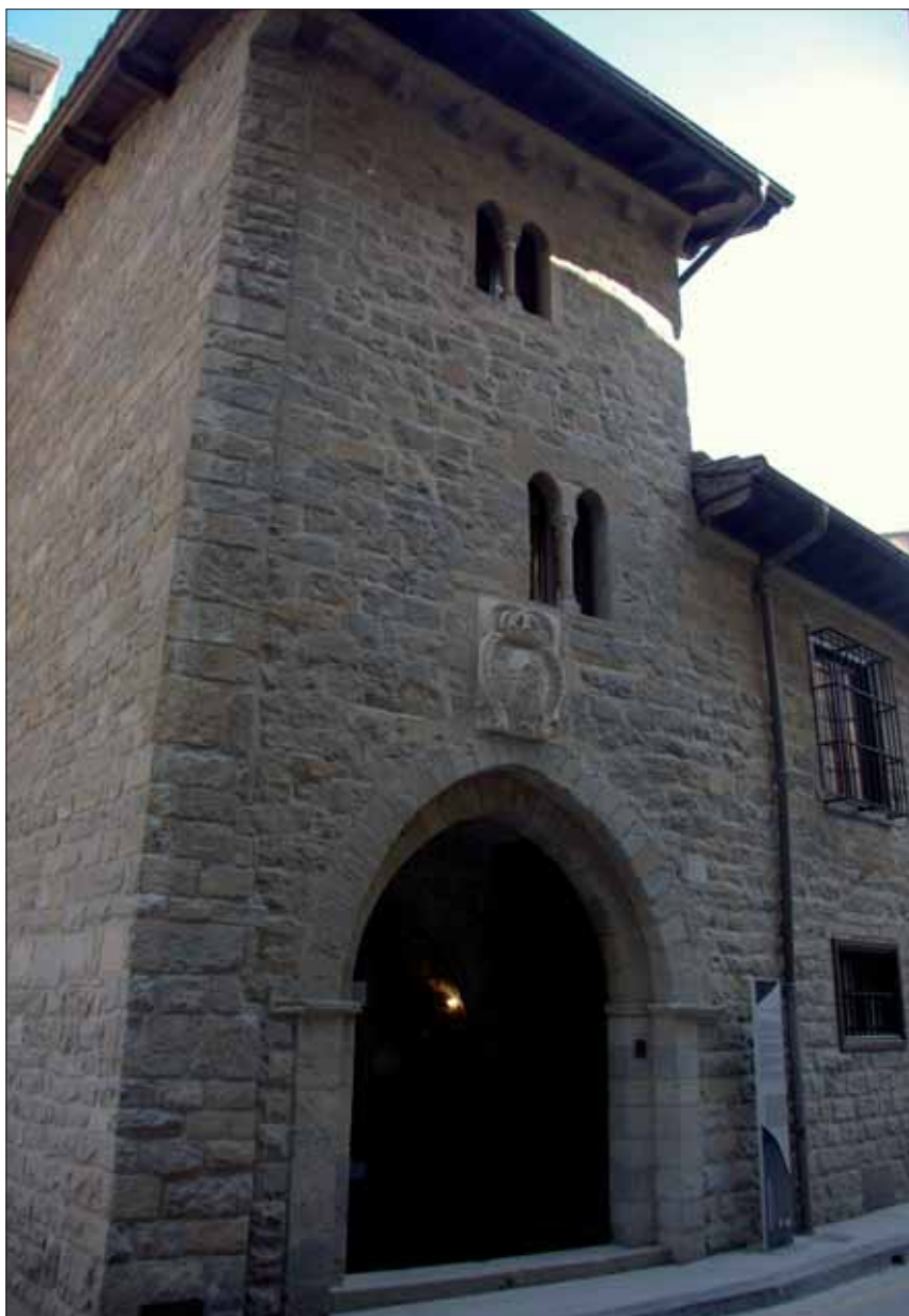
Pamplona, Casa de la Moneda y sede de la Cámara de Comptos, órgano del reino navarro para regular la circulación de moneda y fijar el cambio, además de servir de Consejo en materias de control de cuentas de la Corona. (Foto Tanco Zuza).
