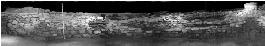
Figura 8: Estructuras del lado oeste del Estanque.
