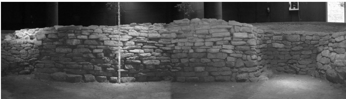
Figura 6: Estructuras del lado sur del Estanque.
