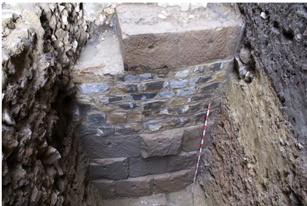
Calle Curia: muro del complejo termal
