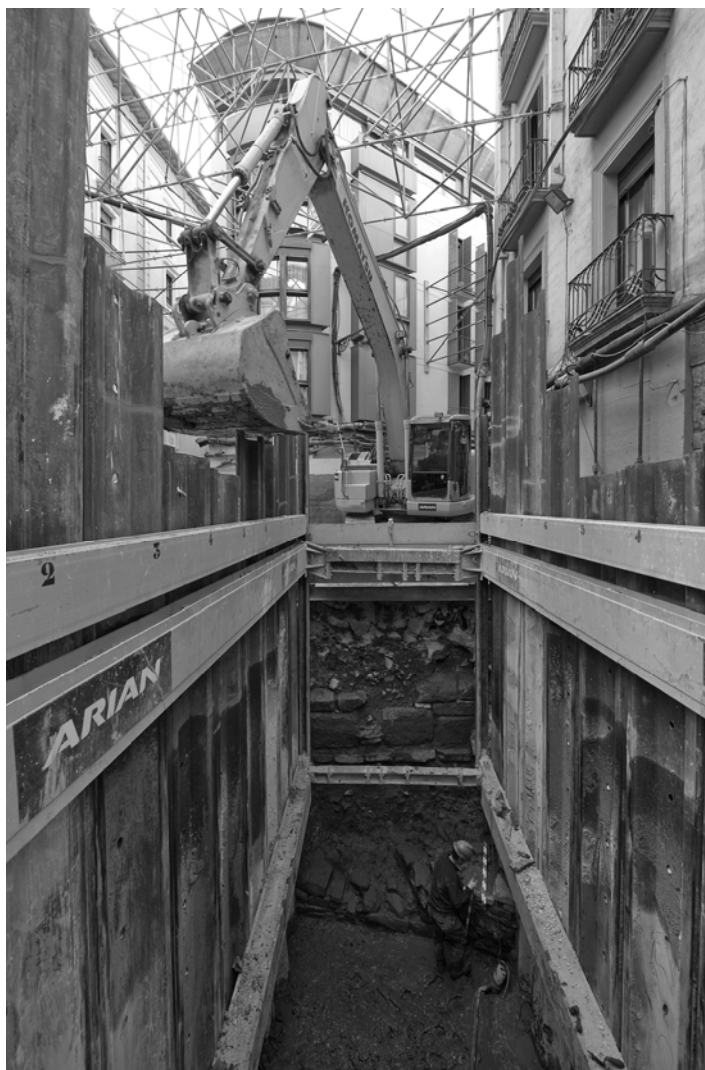
Figura 4. Arqueología urbana: complejidad de la excavación con entibadora y apuntalamientos de los edificios
