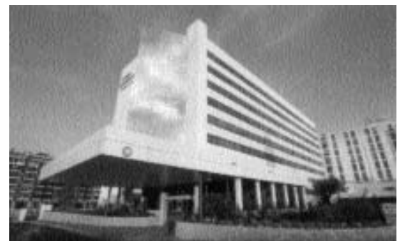
Ampliación de la Clínica Universitaria
