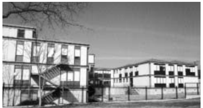
Universidad de Navarra. Edificio de Facultades Eclesiásticas. Ampliación
