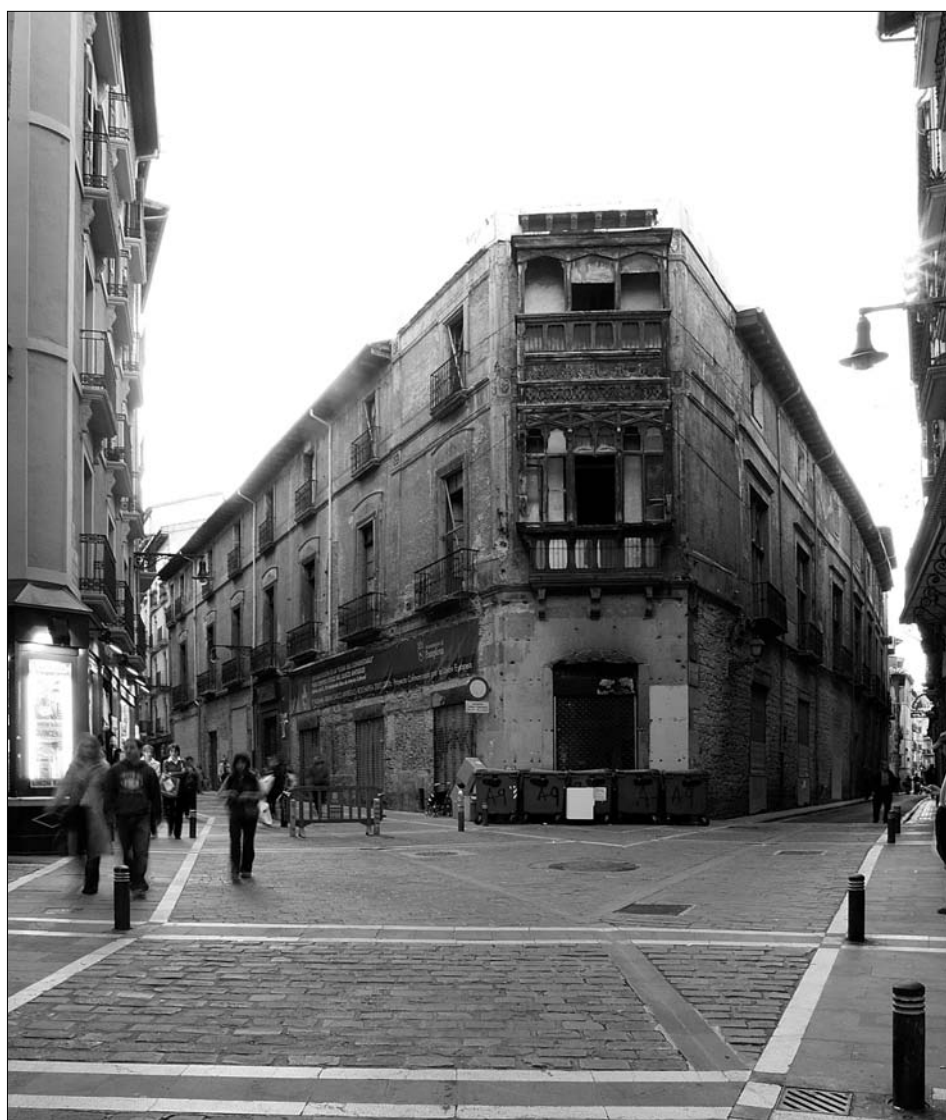
Fig. 1. Fachada. Estado inicial (2001)
