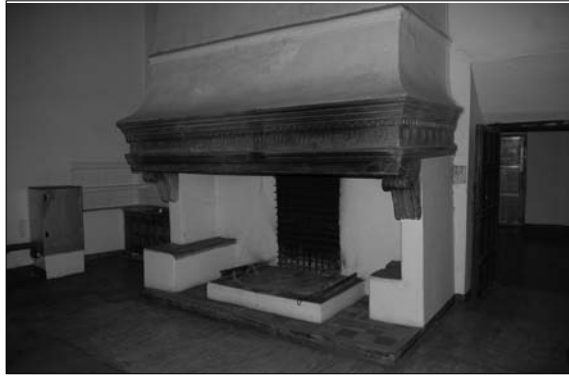
Fig. 26. Zaragoza. Convento del Santo Sepulcro. Chimenea francesa situada en una de las estancias de la clausura utilizada como refectorio. Foto: Javier Ibáñez Fernández.
