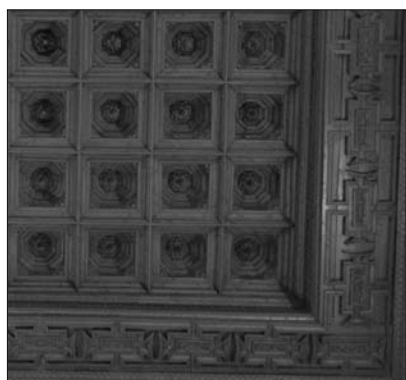
Fig. 32. Zaragoza. Casas del conde de Morata. Planta noble. Sala principal. Detalle de uno de los sistemas de cubierta. Foto: Javier Ibáñez Fernández.
