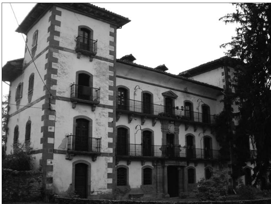
Fig. 9. Palacio Reparacea de Oyeregui.
