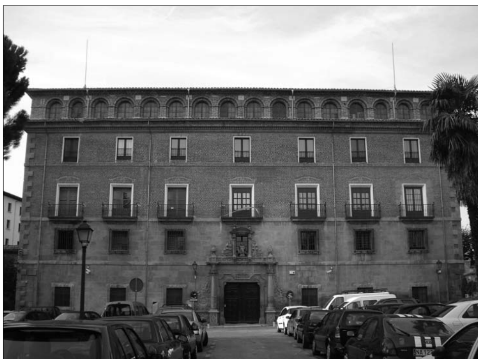
Fig. 4. Palacio episcopal. Fachada.
