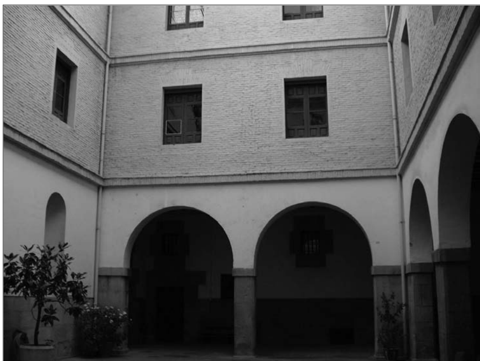
Fig. 1. Palacio episcopal. Patio.
