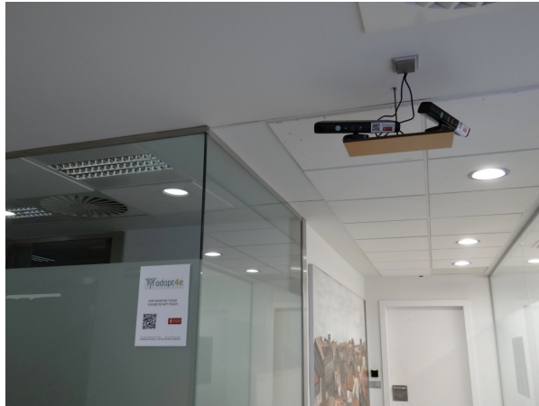
Figura 6. Imagen de la instalación final de dos cámaras Kinect en un pasillo.
