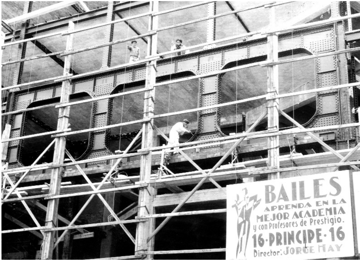
116 Vigas Vierendeel de acero sobre la entrada al cine. Archivo I. Feduchi
