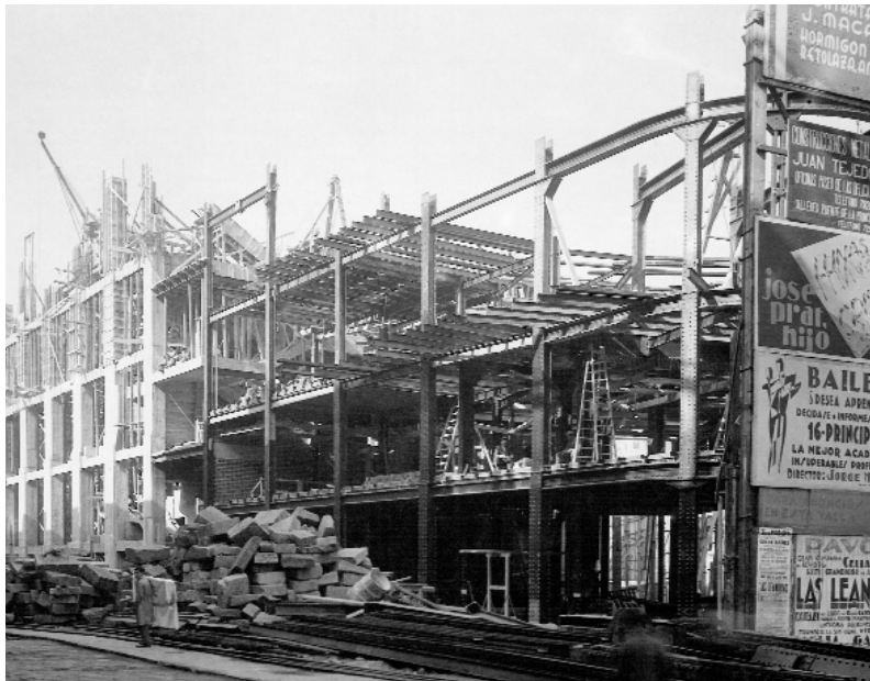
119 Ejecución de la estructura de hormigón y acero en la fachada de Jacometrezo. Archivo I. Feduchi
