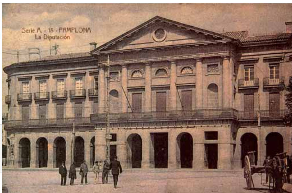
Aspecto original de la fachada principal del Palacio de la Diputación a finales del siglo XIX y principios del siglo XX.
