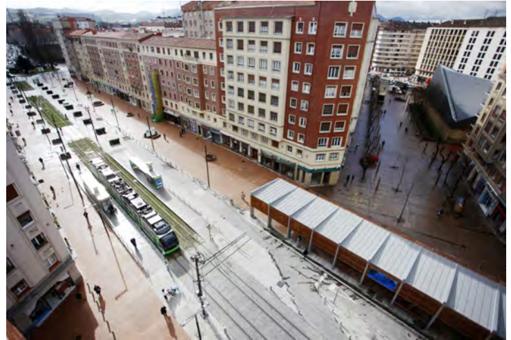
Fig. 3. Transporte público, información y rehabilitación urbana Sancho el Sabio, Vitoria-Gasteiz
