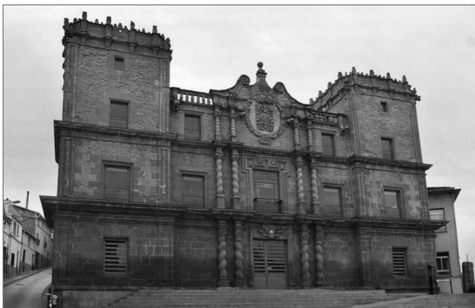
Fig. 1. Casa principal del mayorazgo Vizcaíno en Miranda de Arga.
