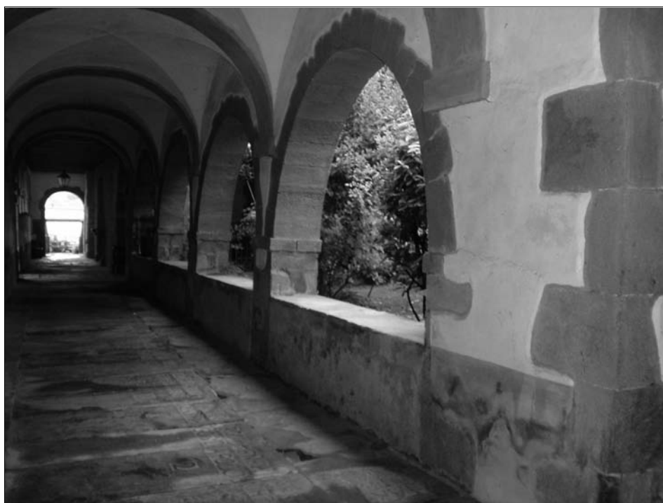
Fig. 16. Vista del claustro de la parroquia de Errazu.
