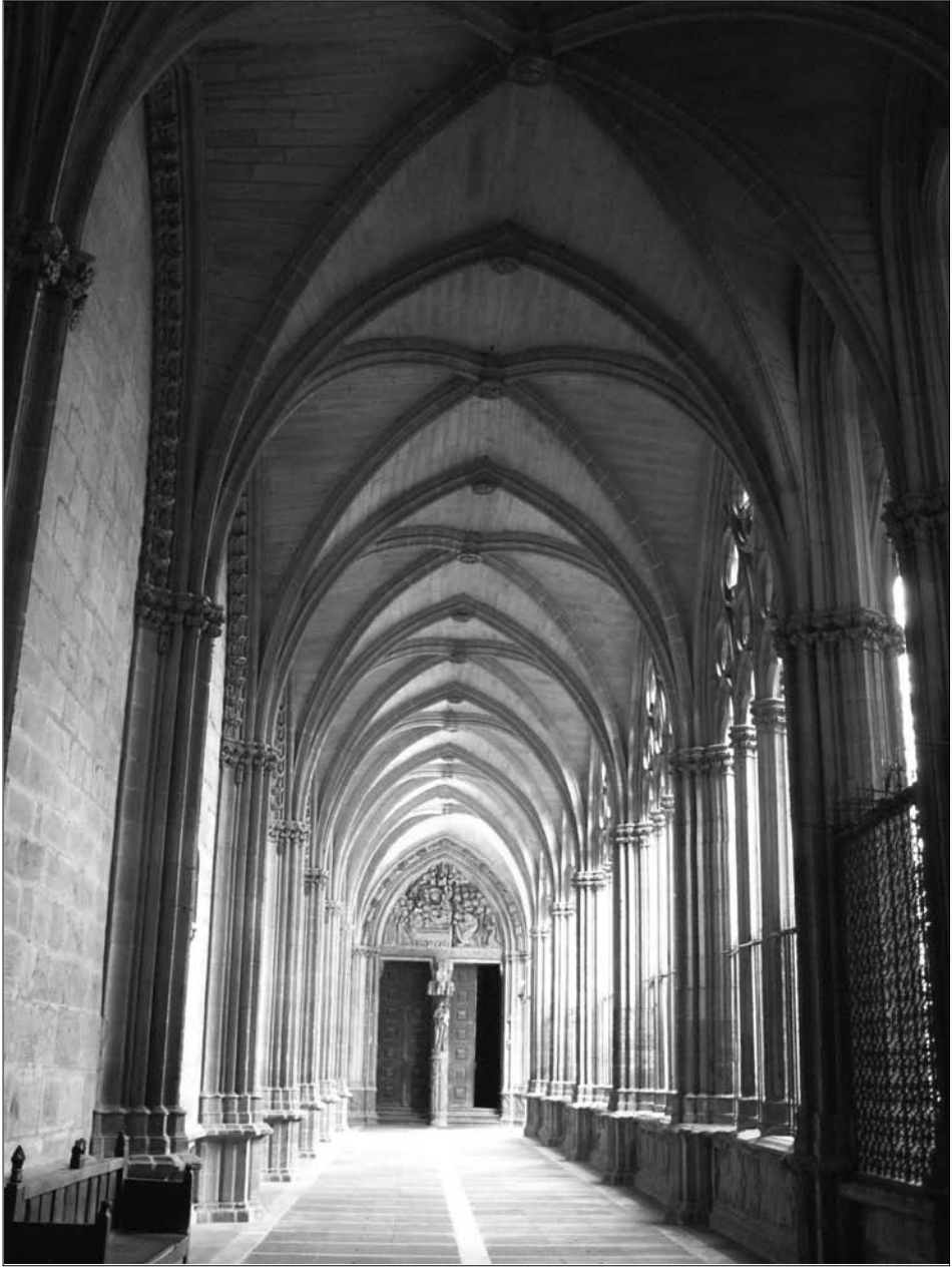
Fig. 1. Vista del ala oeste del claustro de Pamplona, con la Puerta del Amparo al fondo.
