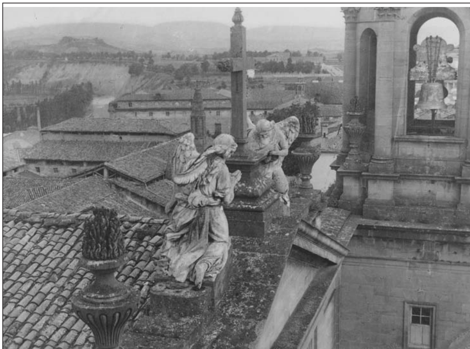
Fig. 5.- Julio Cía. Vista parcial de una de las torres de la Catedral (1932) AMP
