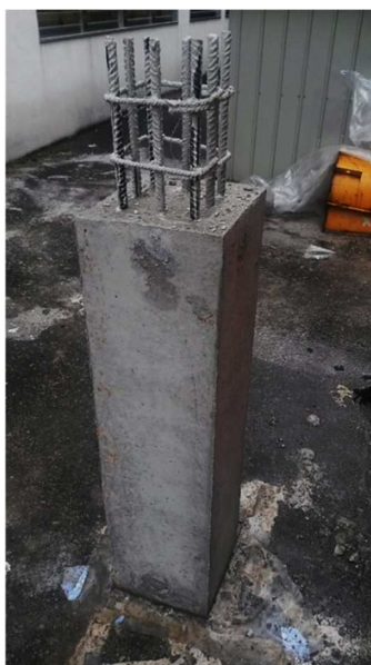
Figura 3.20 Columna realizada con armadura de cuantía máxima.
