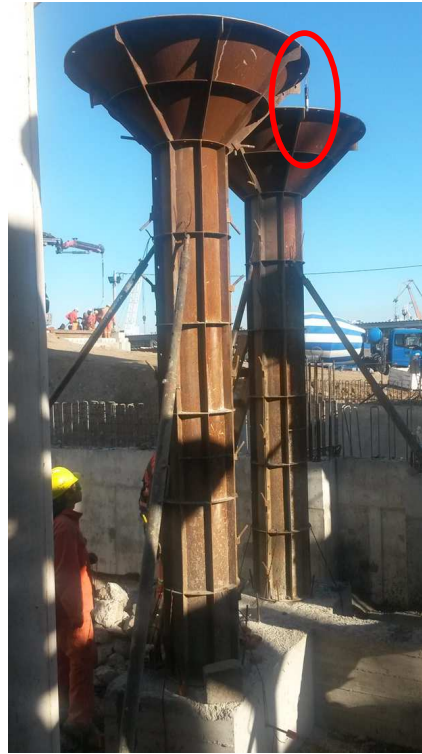
Figura 5.5 Termopar registrando la temperatura del pilar.
