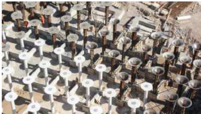
Figura 5.3 Imagen aérea de algunos de los pilares.
