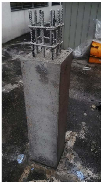
Figura 6.1 Columna realizada con cuantía de armado máxima.
