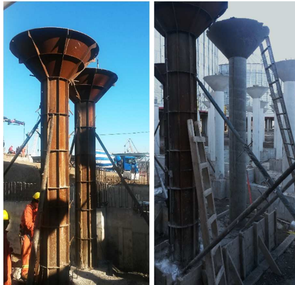
Figura 3.16 Pilar realizado en la obra Obrinel (Montevideo, Uruguay).
