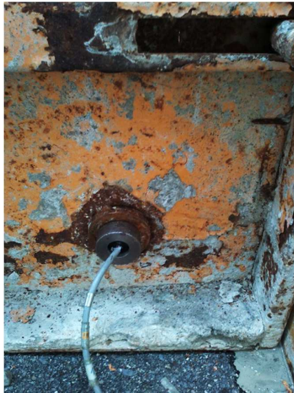
Figura 6.2 Sensor montado en el encofrado LGR.
