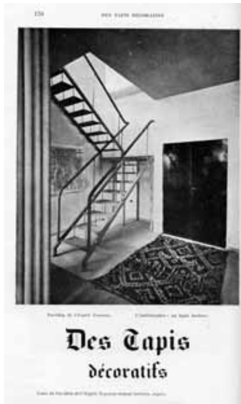
Fig. 5. Le Corbusier, pabellón de L'Esprit Nouveau (1925): alfombra tradicional y escalera "ejecutada mediante construcción tubular soldada". Imagen extraída Le Corbusier, Almanach d'architecture moderne (1925).
