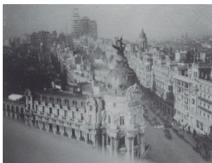
f1_Vista del primer tramo de la Gran Vía desde la azotea del Círculo de Bellas Artes
