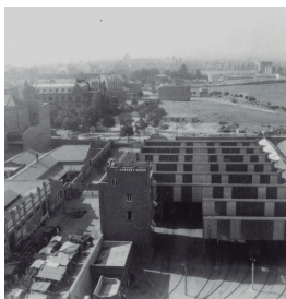
f3_Cocheras del Metro y calle Esquilache
