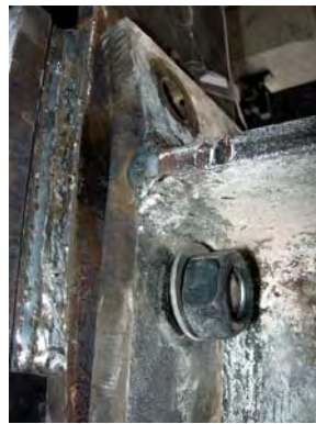
(b) Deformación de la zona de tracción
