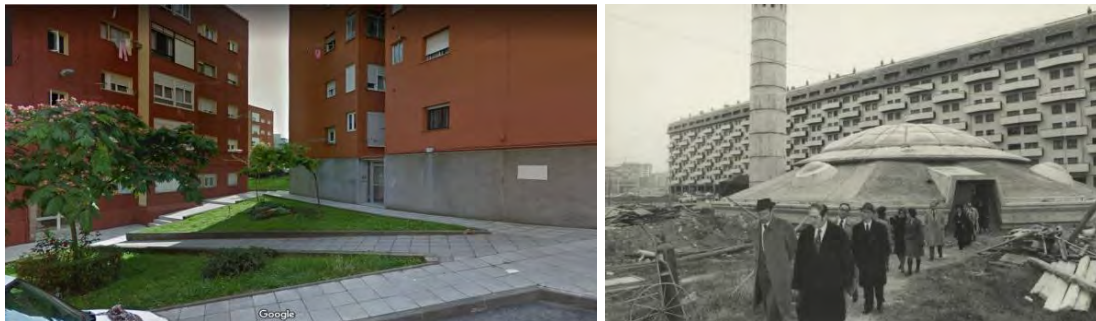
Figura 7. Intervención de renovación del espacio libre en La Colonia Los Pinares de Santander (2007). Fuente: Google maps. Figura 8. Central eléctrica de Txagorritxu: 1974. Fuente: fondo Fotográfico Fundación Sancho el Sabio.
