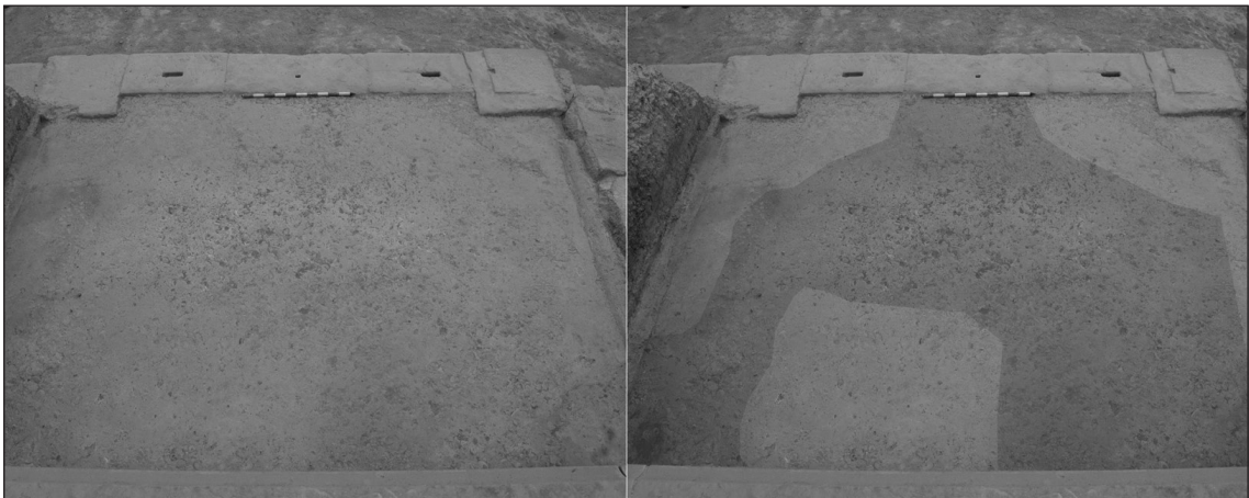
Figura 8. Pavimento de la edícula. A la derecha, resaltado, superficie de mayor desgaste (Foto: Á. A. Jordán).
