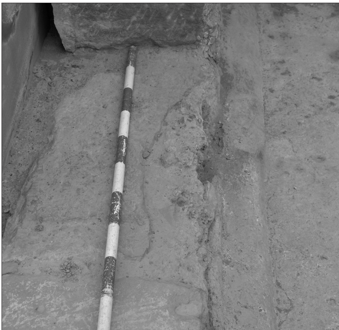
Figura 4. Detalle del muro sur de la edícula, con un sillar fragmentado y relleno con hormigón (Foto: Á. A. Jordán).
