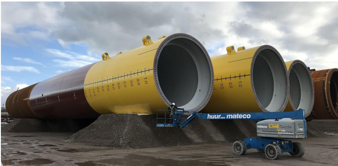
Figura 26 Monopilotes apilados previos a su instalación
