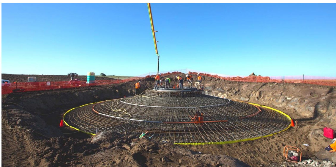
Figura 23 Fotografía de la construcción de una zapata circular para el montaje de un aerogenerador (Fuente: Acciona Energía)
