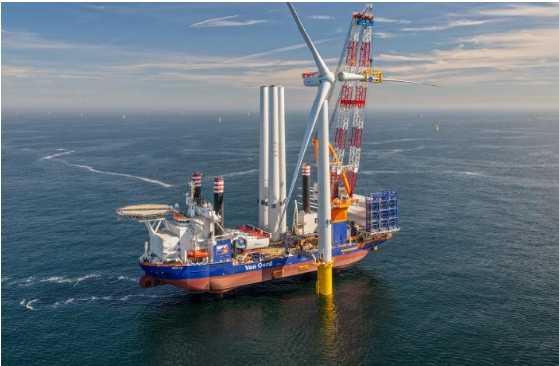
Figura 27 El barco Aeolus en la instalación de una turbina eólica offshore
