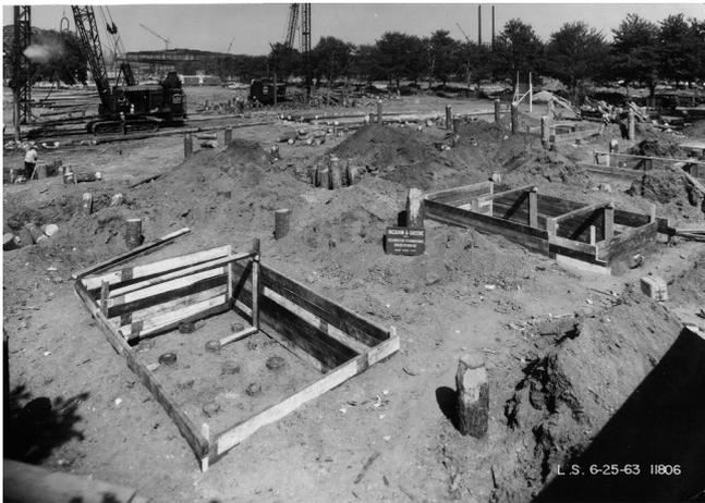
Figura 2. Trabajos de cimentación y pilotaje de madera. 25.6.1963
